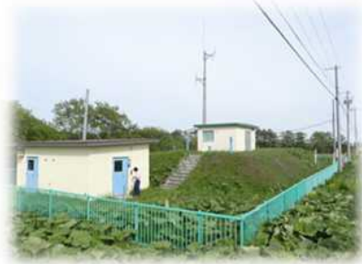
西春別浄水場
