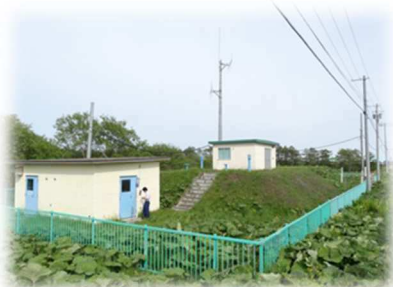
西春別浄水場
