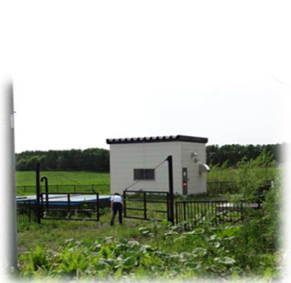
西泉取水井戸（整備中）
