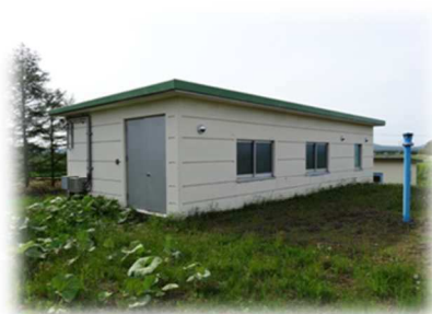
泉川浄水場(深井戸整備中)
